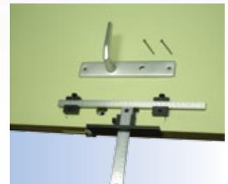
Bohren für Türbeschläge.
