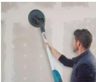
Hohe Schleifkapazität zum Schleifen von Gipswänden.
