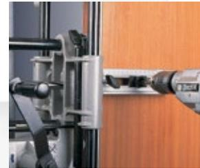
Bei Einsatz des Werkzeugs UT16I erhält man den Bezugspunkt zum Bohren von Zylinderaufnahme und Nadel.
