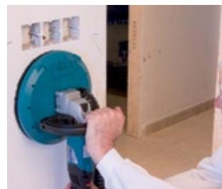
Ermöglicht das Schleifen von Wänden selbst in schwierigen Bereichen.
