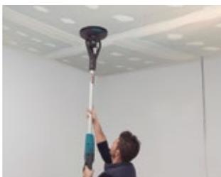
Einfaches Schleifen von Decken.
